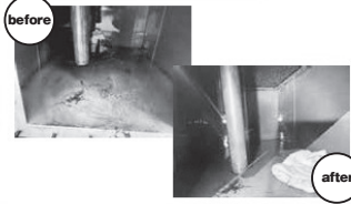
油圧ユニットのタンク清掃と作動油交換
